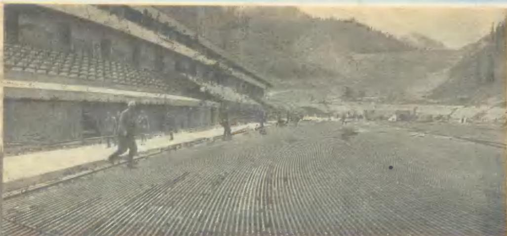
Укладка труб на поле — на фото сверху. **ОСНОВАНИЕ КАТКА:** 1. Грунт. 2. Гравий. 3. Бетонная плита. 4. Армоцементная стяжка. 5. Гидрозащита. 6. Пенопласт. 7. Гидрозащита. 8. Армоцементные стяжки. 9. Слой смазки. 10. Бетонная плита с охлаждающими трубами. 11. Лед. **Фото справа — машины холода. МОРОЗИЛЬНАЯ СИСТЕМА:** 1. Турбокомпрессорные холодильные машины. 2. Поршневые холодильные машины. 3, 4. Насосы.
